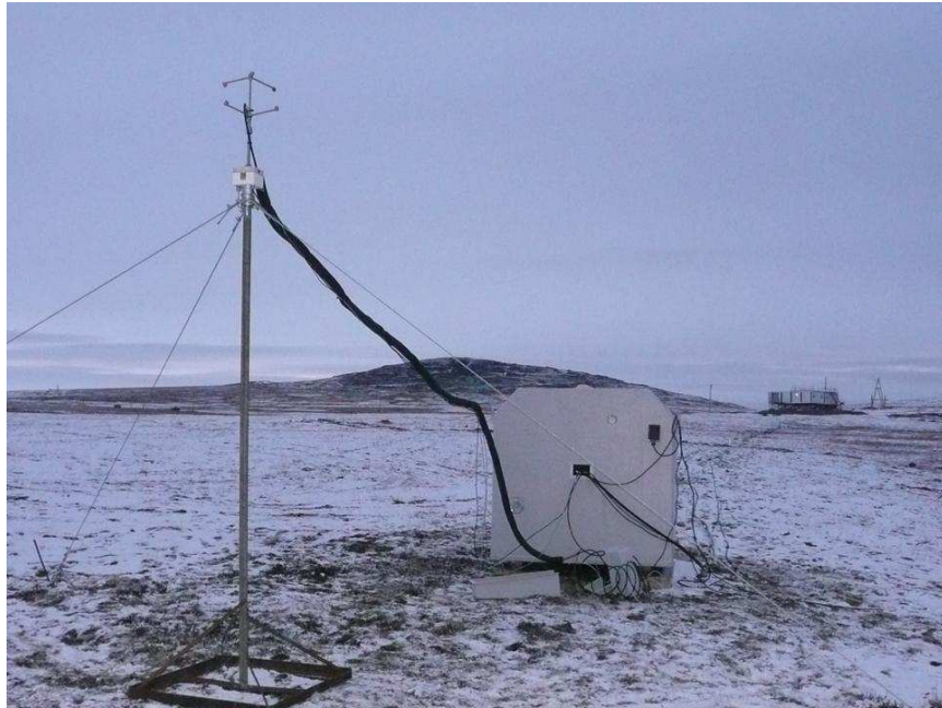
Рисунок 2.13. Установка для измерений турбулентных потоков тепла, углекислого газа и метана над тундрой.
